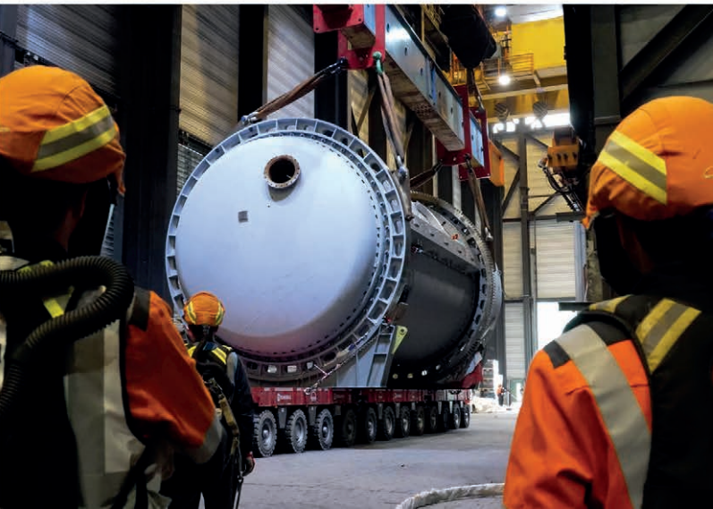
Installation wasserstofffähiger Anodenöfen am Standort Hamburg.
