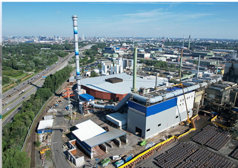
Ausbaustufe 1 der RDE am Standort Hamburg.
